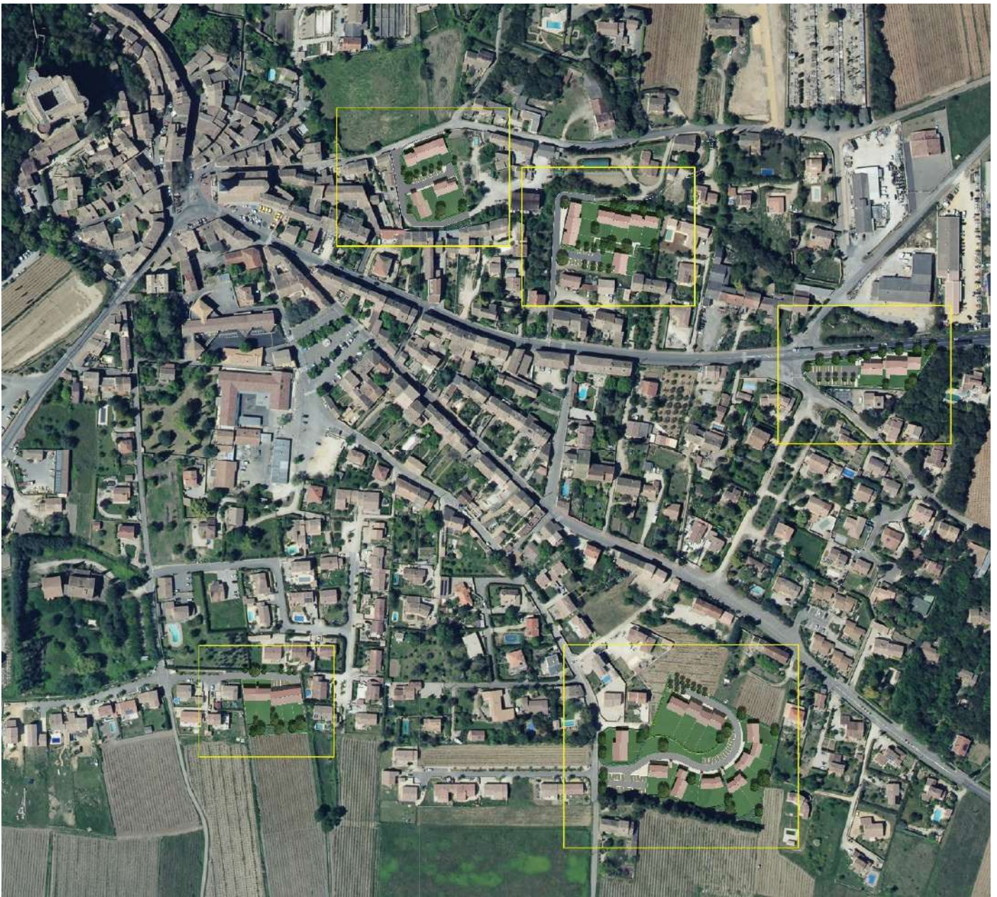
L'urbanisation de densité intermédiaire projetée dans la trame bâtie du village.
