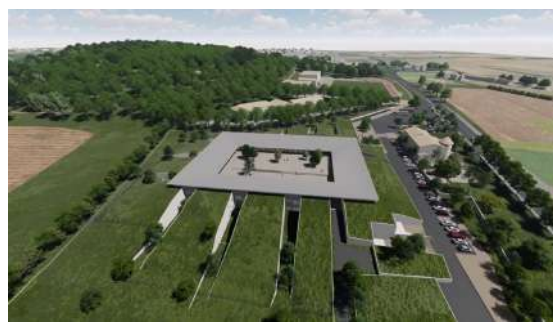
Le nouveau collège et son parti architectural
